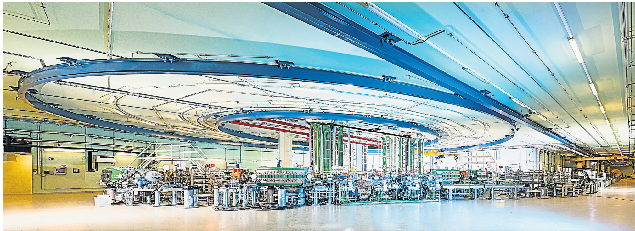
Der Beschleunigerring von Med-Austron bei Wiener Neustadt hat einen Umfang von circa 80 Meter. „Die Presse“ warf einen exklusiven Blick auf den Teilchenbeschleuniger.
